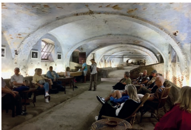
Aile abritant l'étable qui pouvait accueillir plus d'une centaine de vaches et, l'hiver, des travailleurs
