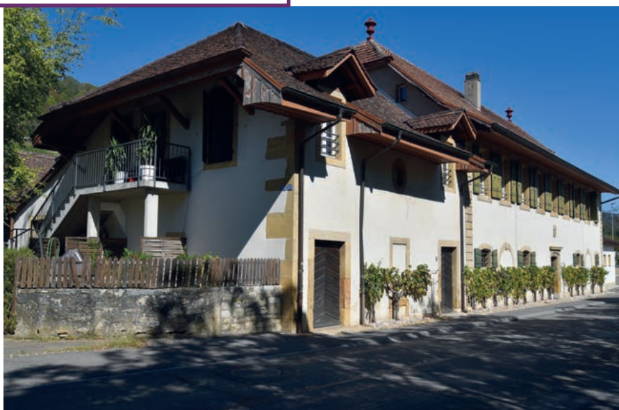
La splendide et historique maison vigneronne du Domaine Pourtalès, route de Troub à Cressier.
